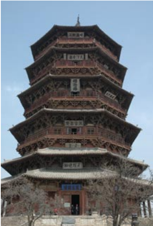
高さ 67 m で世界最大級の木造建築・応県の木塔。
