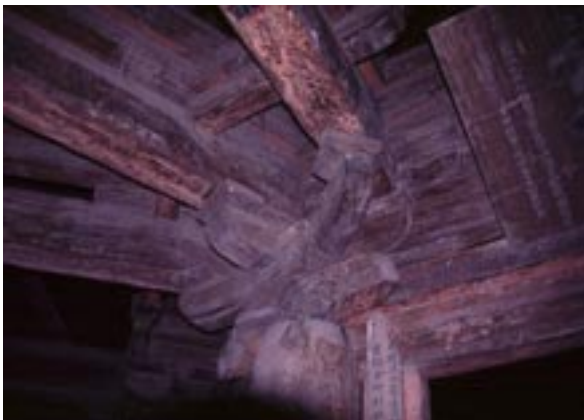
木組みだけで建てられ、鉄釘などは使われていない。
